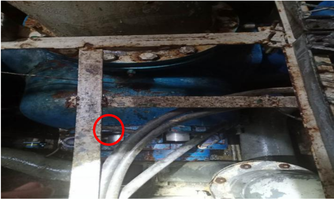
图 7：右舷货油泵左后机械密封
