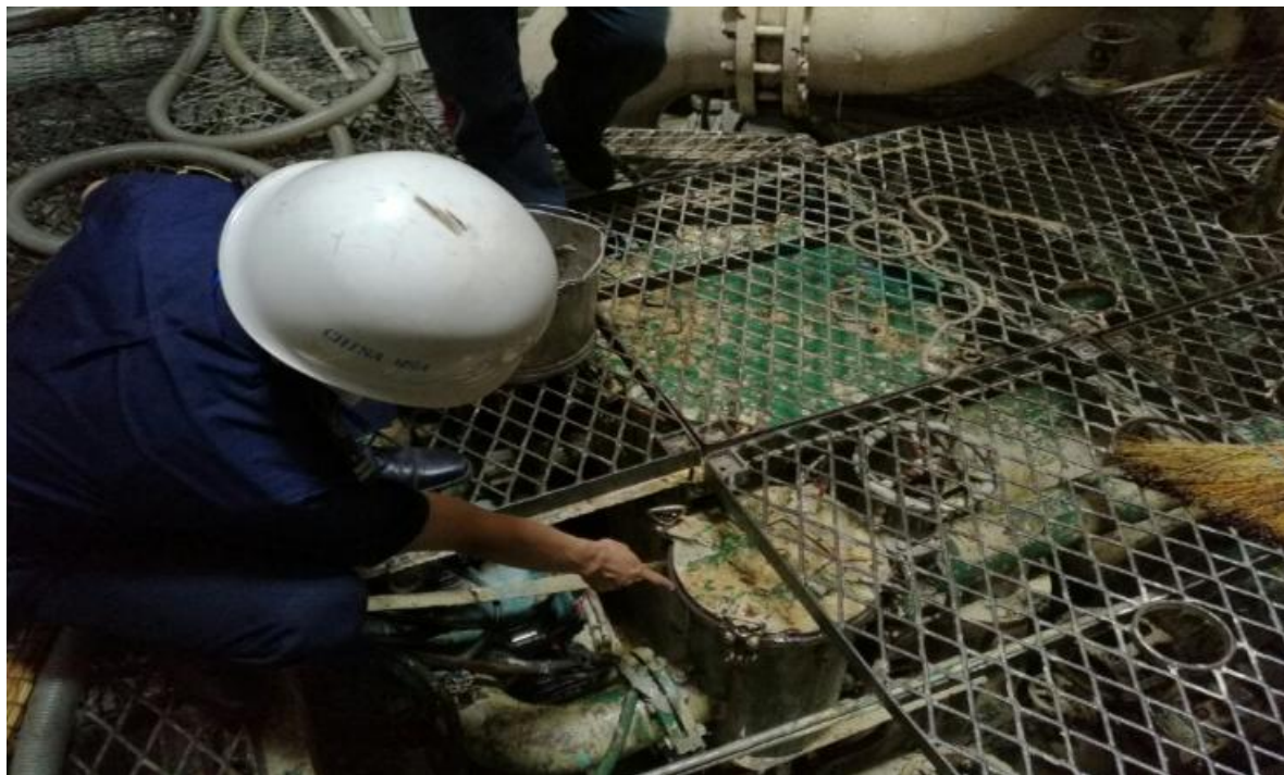
图 5：泵舱勘验情况
