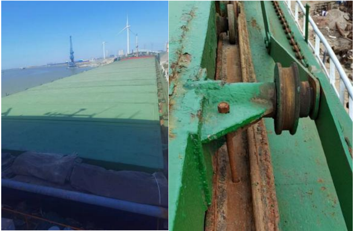
图2：中间检验期间舱口盖的关闭和固定
