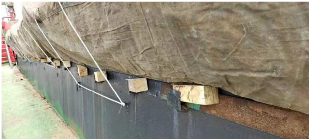
图1：中间检验期间的舱口围板及楔耳、封舱压条和楔子
