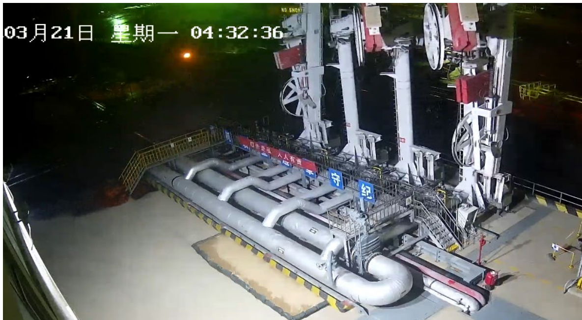
图 11：CCTV CH18 装卸臂脱开后，货油喷出至码头
