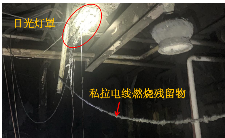
图 8：右主机右前方上部日光灯及私拉电线燃烧残留物
