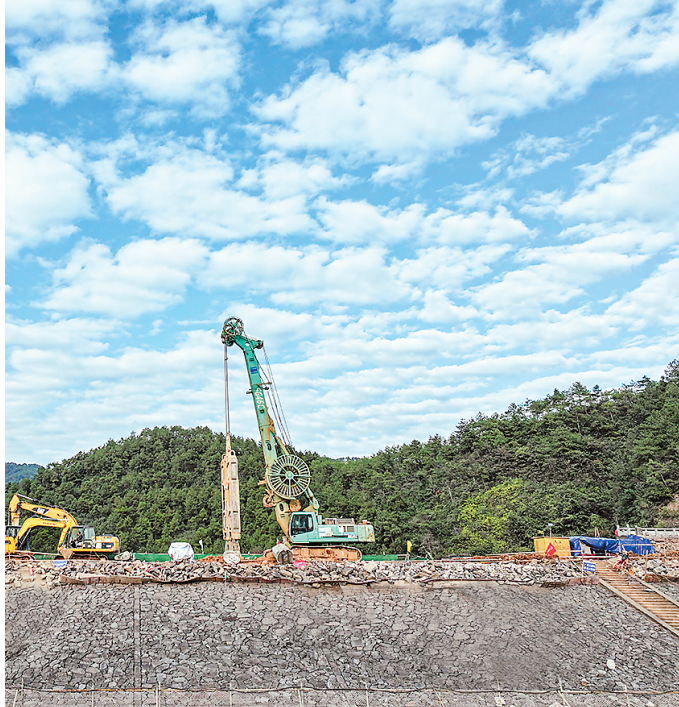
湖南省永州市道县加速推进增发国债水利项目建设，确保项目按时完工，惠及于民。图为道县麻洞水库除险加固项目施工现场。（人民视觉）
