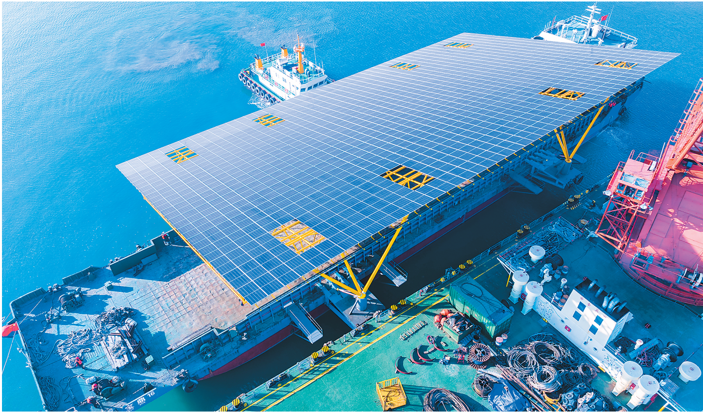
1月11日，“宝鼎16”轮载运中电建青岛即墨海上光伏项目第一组钢平台离开码头，驶往山东青岛市即墨区鳌山湾水域进行海上安装。该项目系中国首个渔业融合发展海上桩基固定式光伏项目，也是目前中国开放海域最大渔光互补示范类项目。项目将渔业与光伏产业深度融合，实现海洋资源综合利用、精准养殖，不仅能高效利用海洋资源，还能促进海上光伏发电事业的发展。
