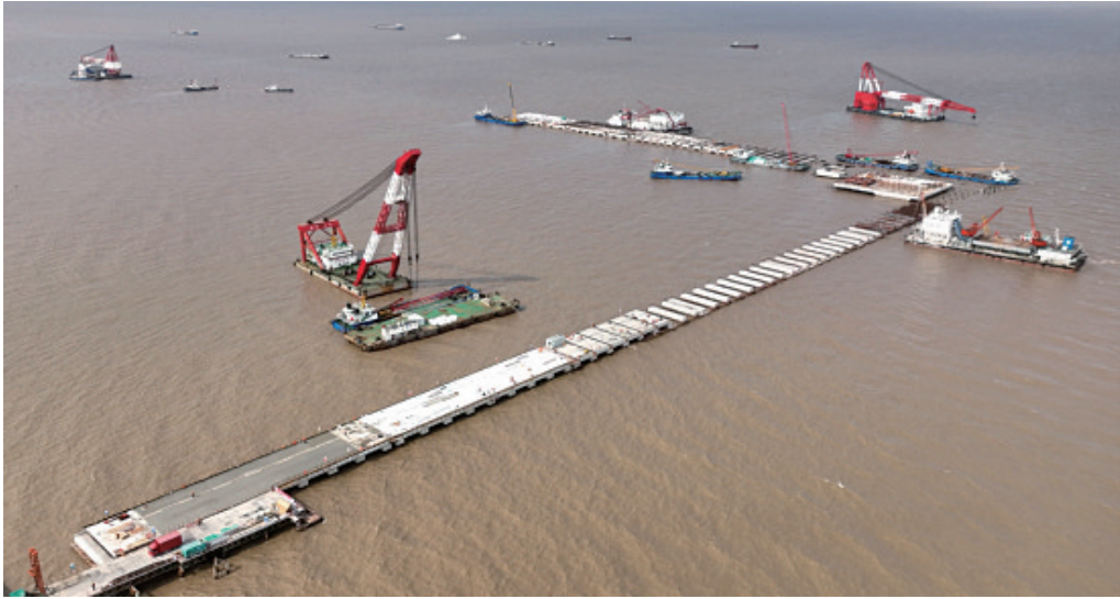
崇明海事局横沙海巡执法大队使用无人机保障横沙新洲码头建设项目安全高效施工。
