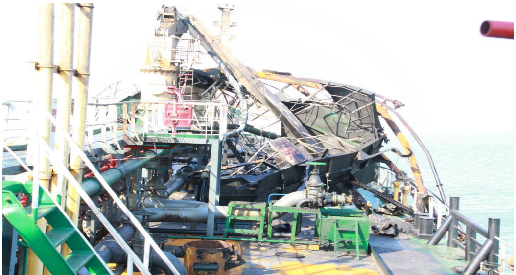
图 4： 步桥及起重设备受损情况
