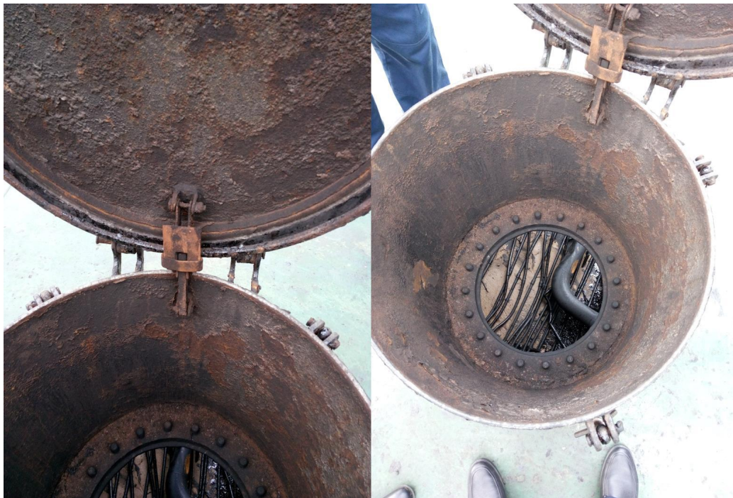
图 7：实施电焊作业的相同部位（实际施工部位已不存在）
